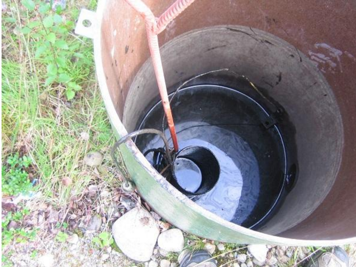
Hälytinturi kiinni irtonaisessa putkessa
