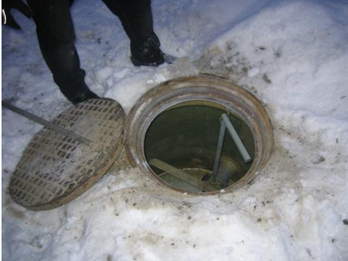
Tarkastus- ja sulkuventtiilikaivo, asennus 2012
